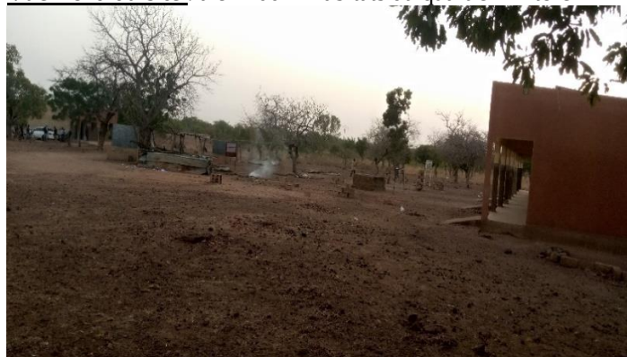
Vue globale du site avec la présence d'un bâtiment de quatre (04) classes dans le village Zongbèga, quartier Rapoya
